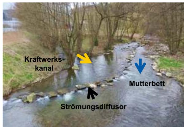
Abb.1: Beispiel eines Strömungsdiffusors an der Diemel [Maria Zimmermann]
