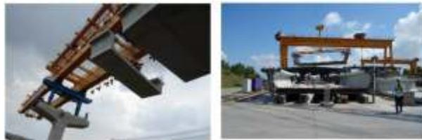
Bau der Hochbahn / U-Bahn aus Fertigbetonteilen
