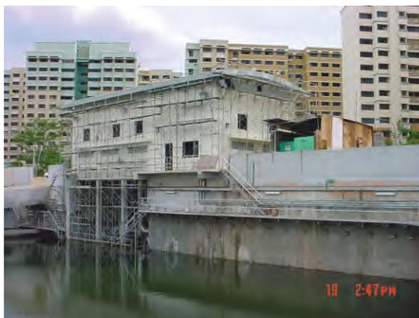
Regenüberlaufbecken in Singapore  $V = \text{ca. } 140.000 \text{ m}^3$  mit Pumpstation und 54 HydroSelf Schwallspülungen zum Reinigen des Beckens
