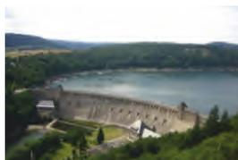
Das Hochwasserrückhaltebecken Treysa mit Heberentlastung
