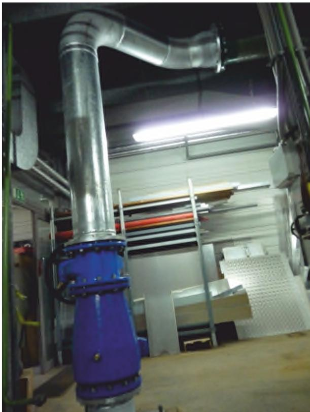
neue Druckrohrleitung mit Rückschlagklappe als Anschluss an die Bestandsrohrleitung
