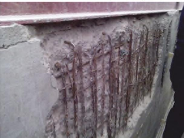
Schadensbild an der Betonverkleidung der Tiefrinne
