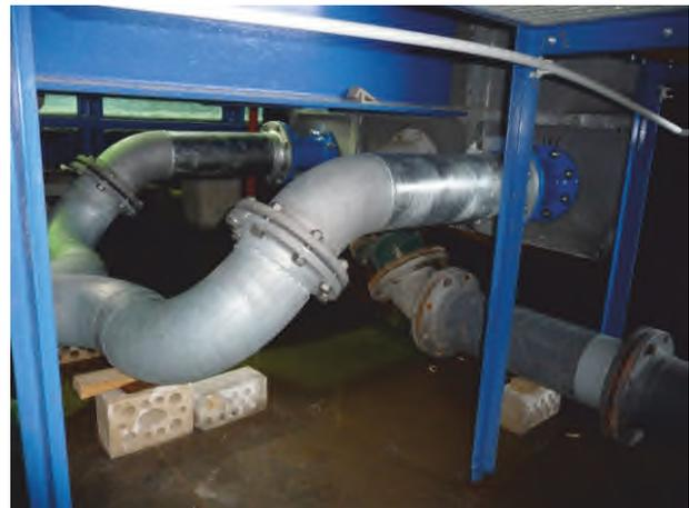
erweiterte Zuleitung zum Anschluss beider Hochbehälter
