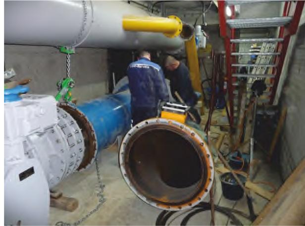
**Pumpen (Ausbau / vor Instandsetzung)**
