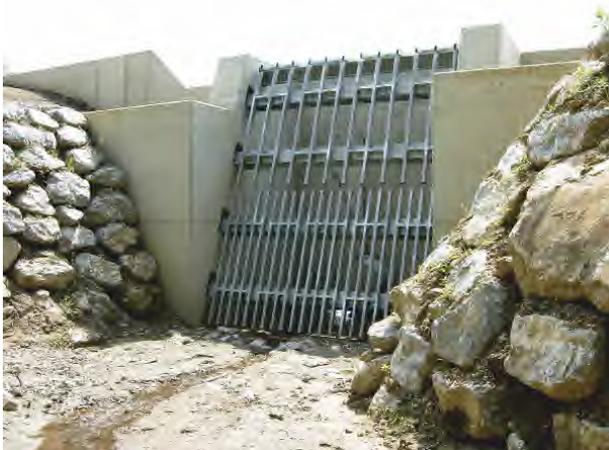
*HydroLatch Hochwasserrückhaltebecken Graz mit Entlastungsbauwerk, integrierten Überlauf, Einlaufgitter und HydroSlide Hochwasserentlastungsregler*
