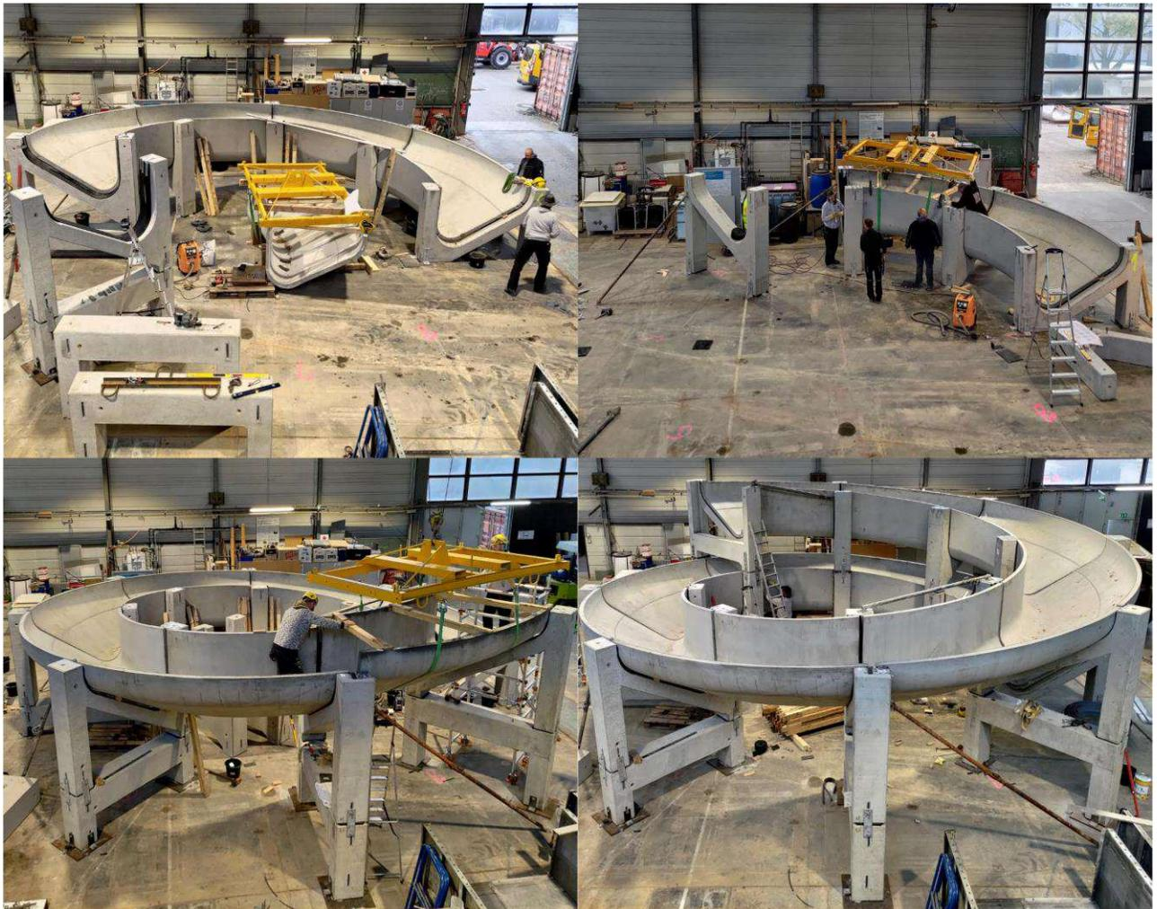
Abbildung 26: Aufbau der modularen Unterkonstruktion und Halbschalenrinnen
