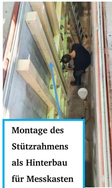
**Montage des Stützrahmens als Hinterbau für Messkasten**
