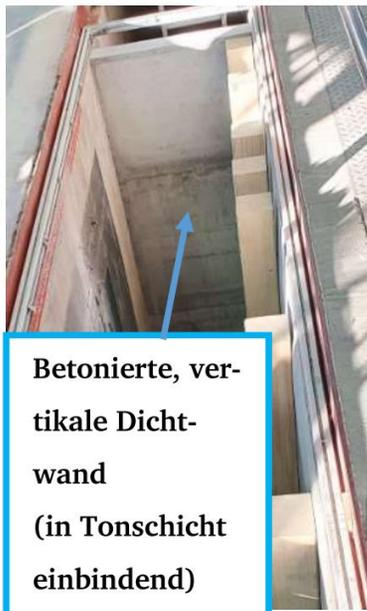
**Betonierte, vertikale Dichtwand
