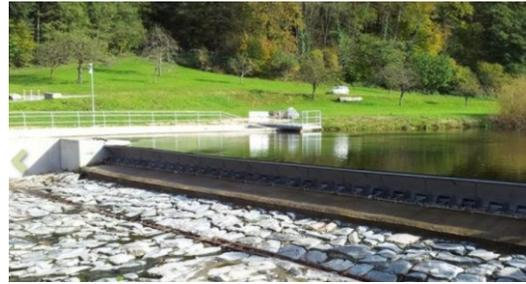
Abbildung 20: Prototypausführungen Federwehr (Quelle: Josef Wiegand GmbH & Co KG)
