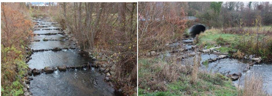
Abbildung 4: Sanierung der Wehrplatte durch eine Riegelrampe in Nieder-Ramstadt
