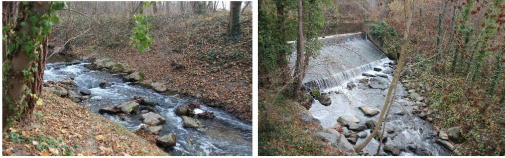
Abbildung 2: Praxisbeispiele für Sohlenbauwerke; links: Steinrampe am Sandbach; rechts: Betonwehr an der Modau
