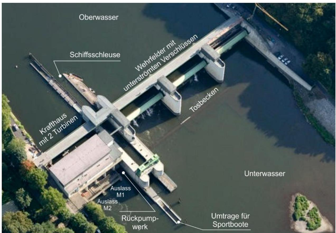
Abbildung 24: Das Stauwehr Baldeney/Ruhr mit Kraftwerk und Schiffsschleuse
