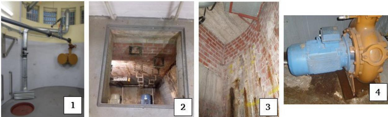
Abbildung 9:(1) Einstieg zum Mischwasser-Pumpensumpf im Maschinenraum (aus: Born & Ermel 2014); (2) Erschwelter Einstieg in den engen Pumpenschacht über Steigeisen; (3) Ausblühungen an der Innenwand des Pumpenschachts weisen auf starke Feuchtigkeitsschäden hin; (4) Korrosionserscheinungen an Grundlastpumpe 1 durch eintretende Feuchtigkeit im Pumpenschacht
