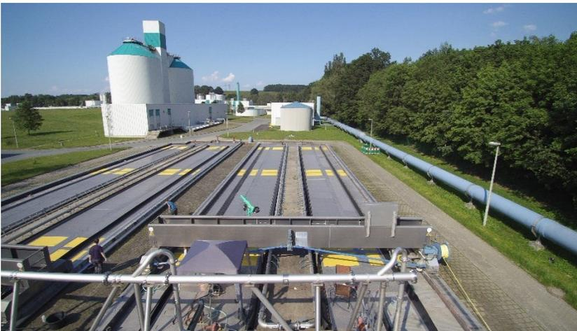
Abbildung 33: UAV-Luftaufnahme mit Blick vom Zulaufkanal auf die zwei Doppelkammersandfänge
